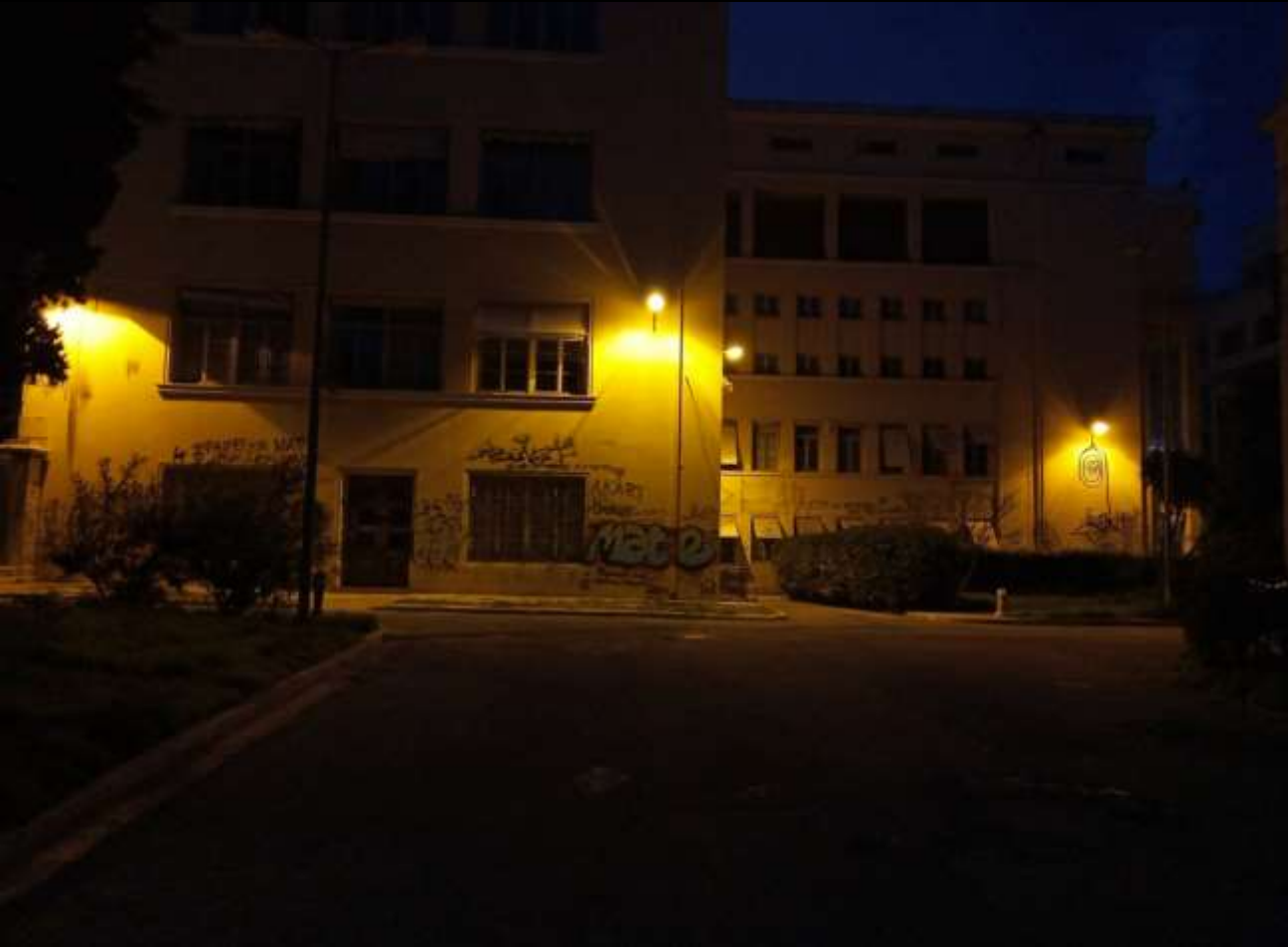
70 φωτιστικά High Pressure Sodium, 21kW
